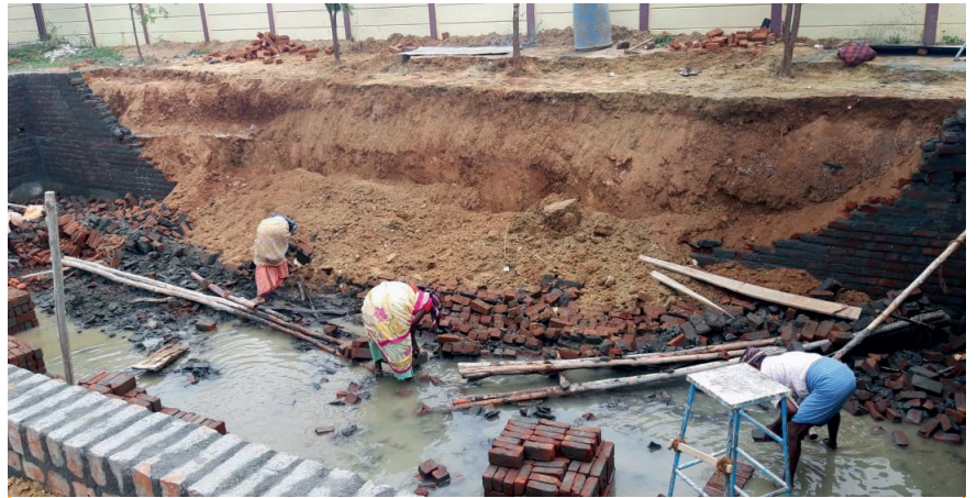
Die Zisterne wird in gemeinschaftlicher Arbeit gebaut
