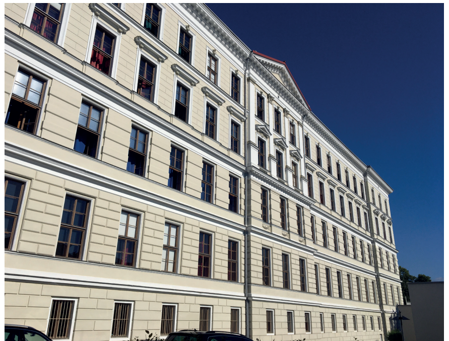
Die neu sanierte Fassade des Petrinum
